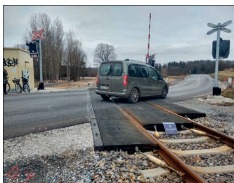
Železniční přejezd P1355 Hřibárna
