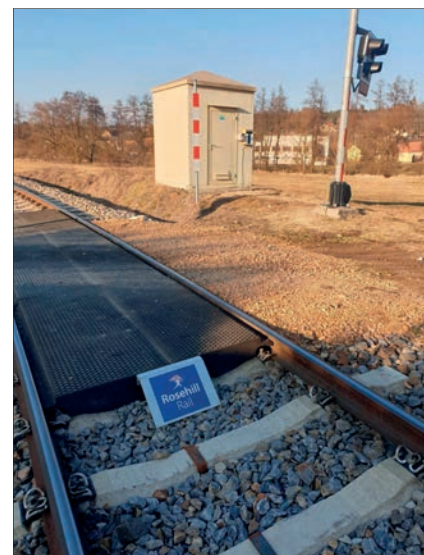
Železniční přejezd P1341 Bezdědovický zářez
